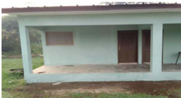
Nouvelle chambre aménagée
