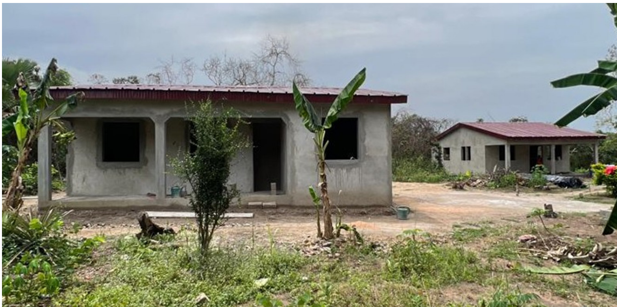
Nouveaux bâtiments en construction sur le site expérimental de la Station de Bringakro
